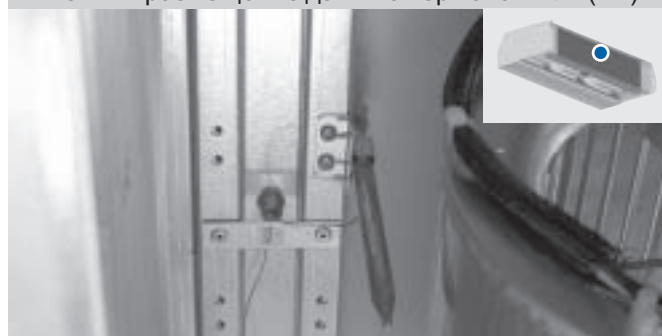
Рис. 17 – размещение датчика термовентилля (D2)
