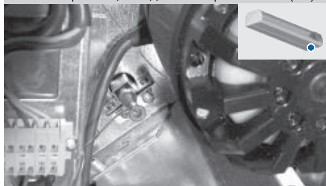
Рис. 17 – размещение датчика термовентилля (D2)
