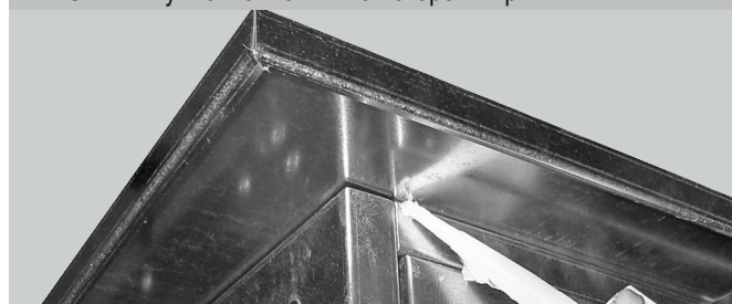
Рис. 12 – уплотнение нижней стороны крышки
